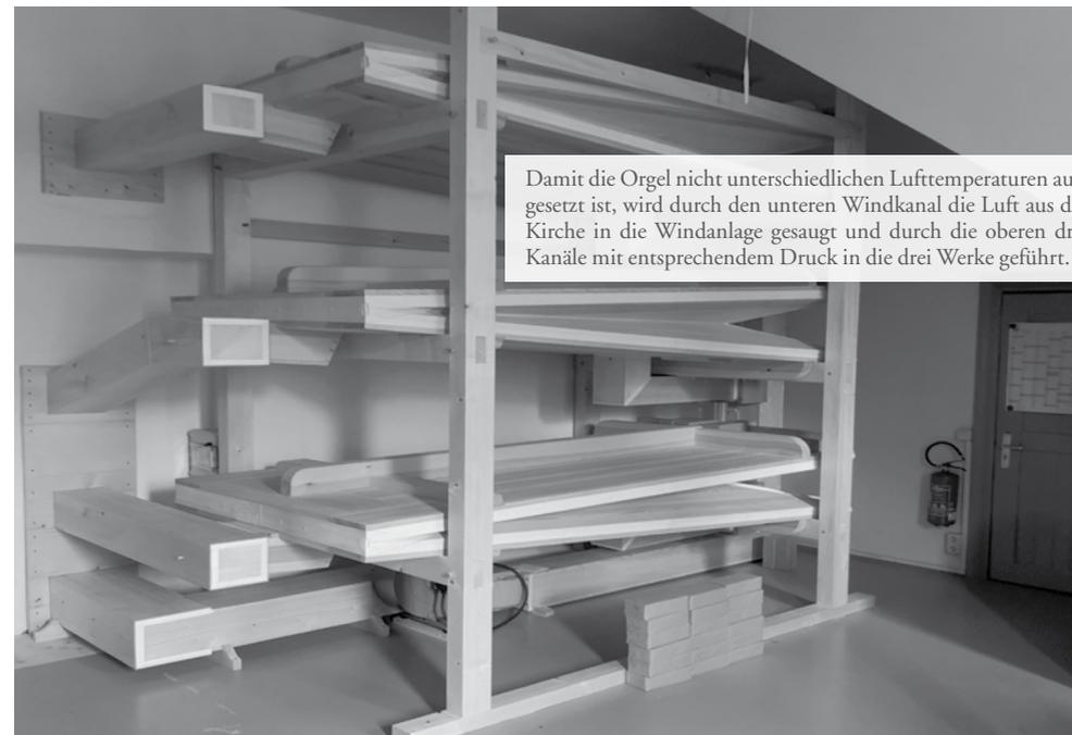
Damit die Orgel nicht unterschiedlichen Lufttemperaturen ausgesetzt ist, wird durch den unteren Windkanal die Luft aus der Kirche in die Windanlage gesaugt und durch die oberen drei Kanäle mit entsprechendem Druck in die drei Werke geführt.
